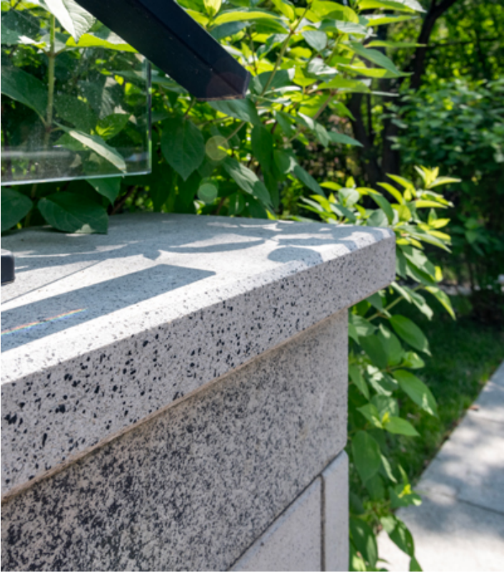
EDGE CHAMFERED EDGE DETAIL
